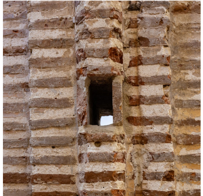
Foto 25: Mechina que perfora el segundo pilar compuesto de la arquería de la epístola.
