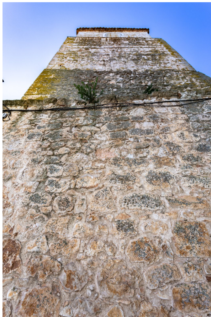
Foto 9: Vista desde la base de la fachada septentrional de la torre del templo.
