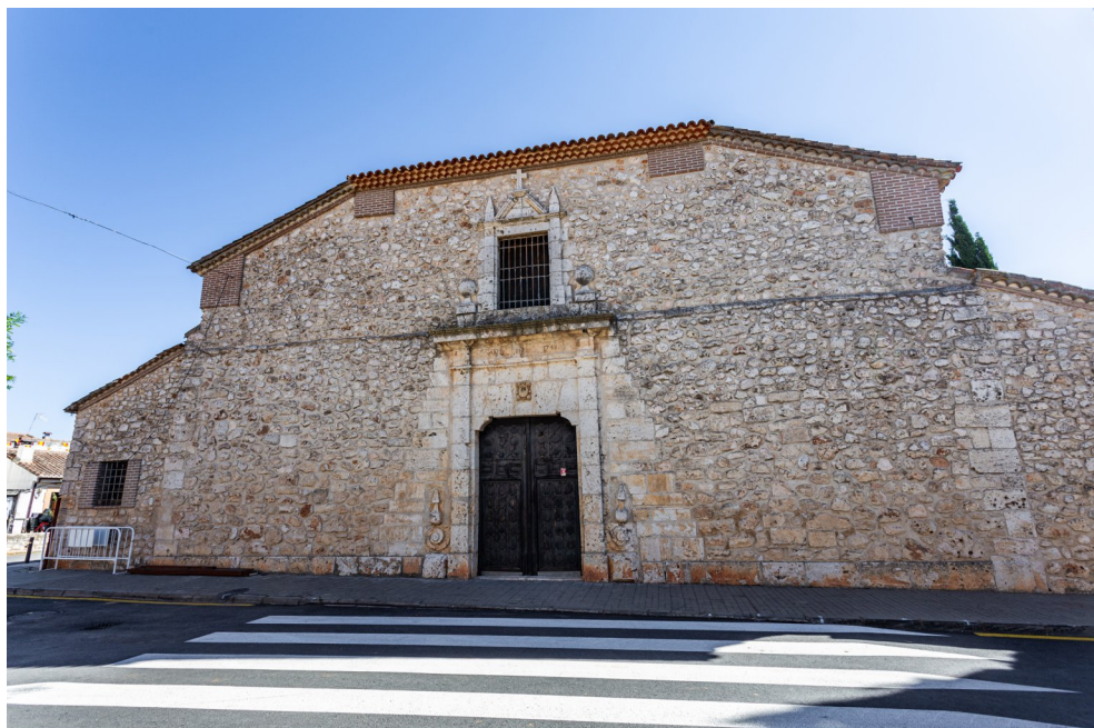
Foto 3: Fachada principal del templo a la Calle Mayor, configurada en mampostería de disposición irregular, reservándose la sillería para la portada, así como para las esquinas de las naves laterales, según la reforma del siglo XVIII.
