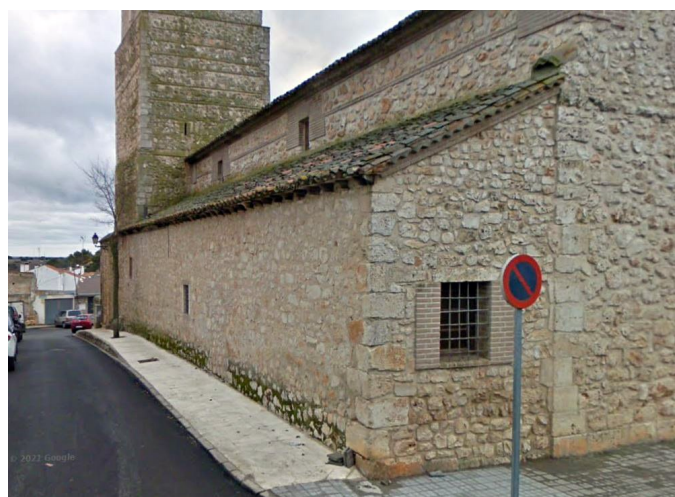
Foto 10: Fachada septentrional del templo, añadida a la nave del evangelio a modo de larga nave en el siglo XVIII.
