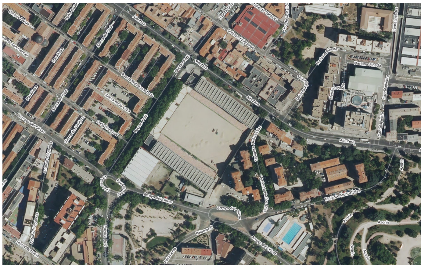
Fotografía aérea actual de la zona, que muestra lo encajonado del campo entre las calles y edificaciones que han surgido a su alrededor. Una opción que implique aumentar el número de localidades, por fuerza requerirá grandes reconstrucciones o demoliciones.
