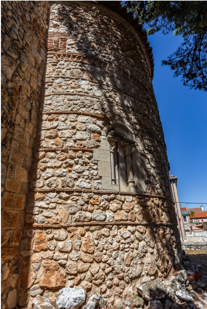
Foto 5: Fachada meridional del ábside, en cuya parte superior se aprecia el friso de ladrillos en esquinilla, o "dientes de sierra".
