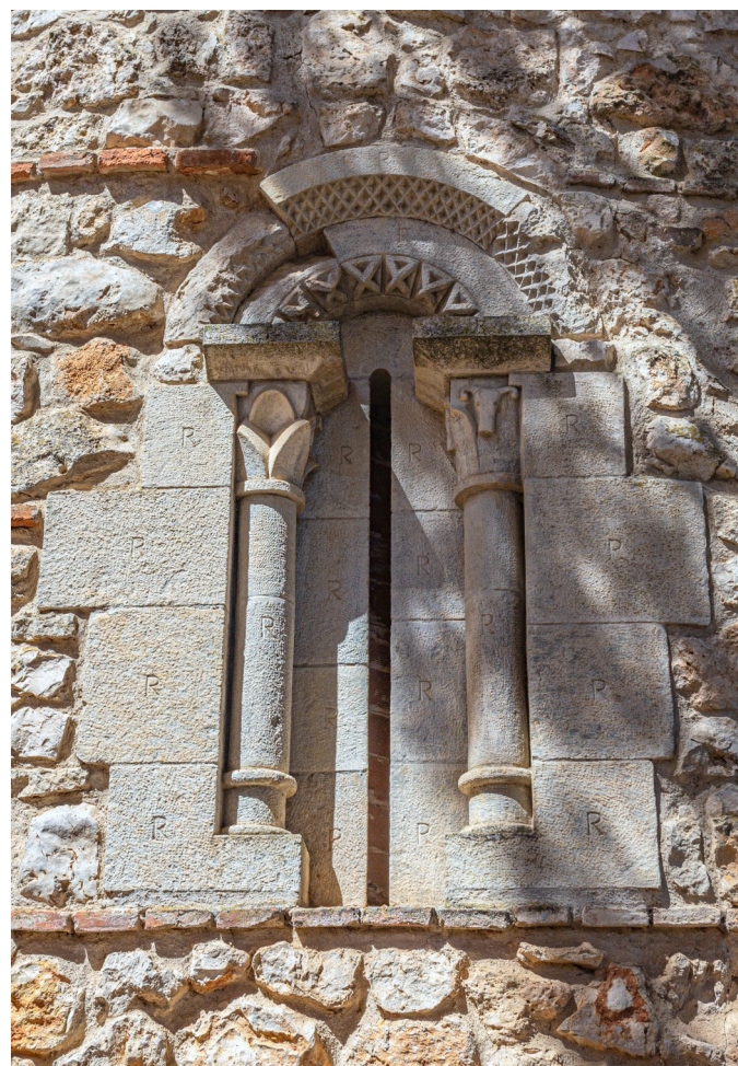
Fotos 7 y 8: Ventanas central y meridional, muy restauradas siguiendo el ejemplo de la ventana septentrional, apareciendo marcadas las piezas repuestas con la letra "R".
