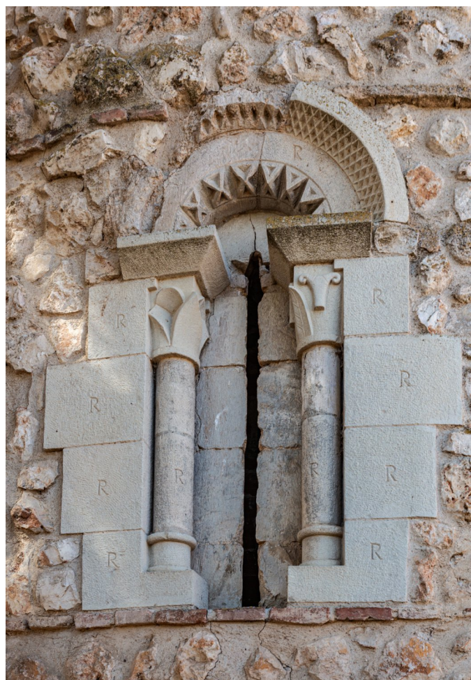
Fotos 7 y 8: Ventanas central y meridional, muy restauradas siguiendo el ejemplo de la ventana septentrional, apareciendo marcadas las piezas repuestas con la letra "R".
